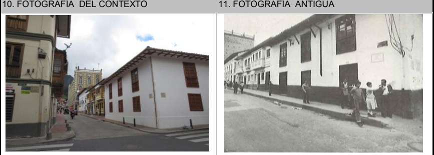
Fuente: Equipo Fotografía PEMP Patrimonio Inmueble Fuente: No documentado
