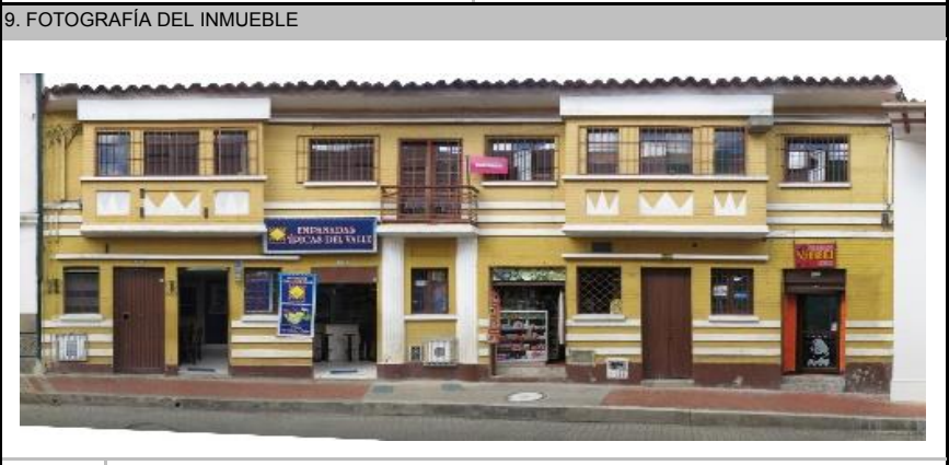
Fuente: Equipo Fotografía PEMP Patrimonio Inmueble
